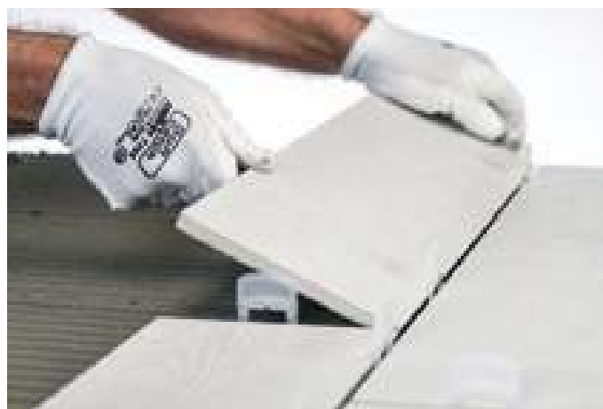
układanie płytek
