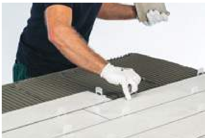
montaż klipsów jednorazowych
