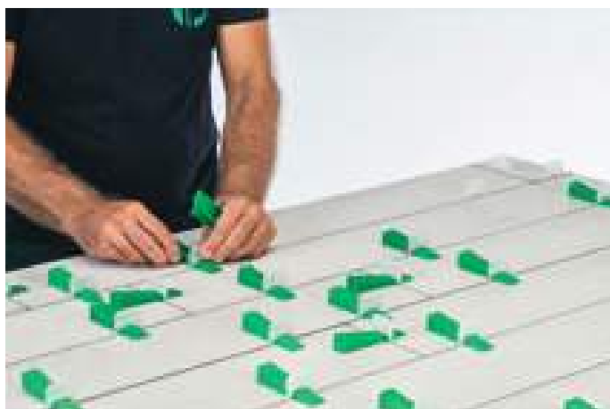
montaż klinów wyrównujących
